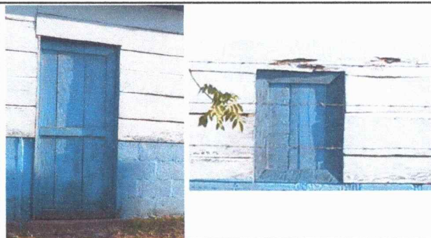
Foto 6: Cambio de puerta y ventanas.
