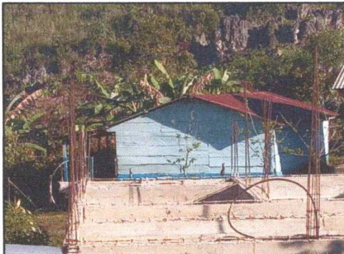
Foto 2: Estructura de techo.
