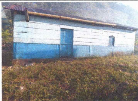
Foto 5: Cambio de estructura y cubierta en cocina.
