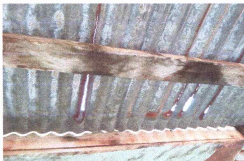
Foto 4: Cambio de techo y viga de metal.
